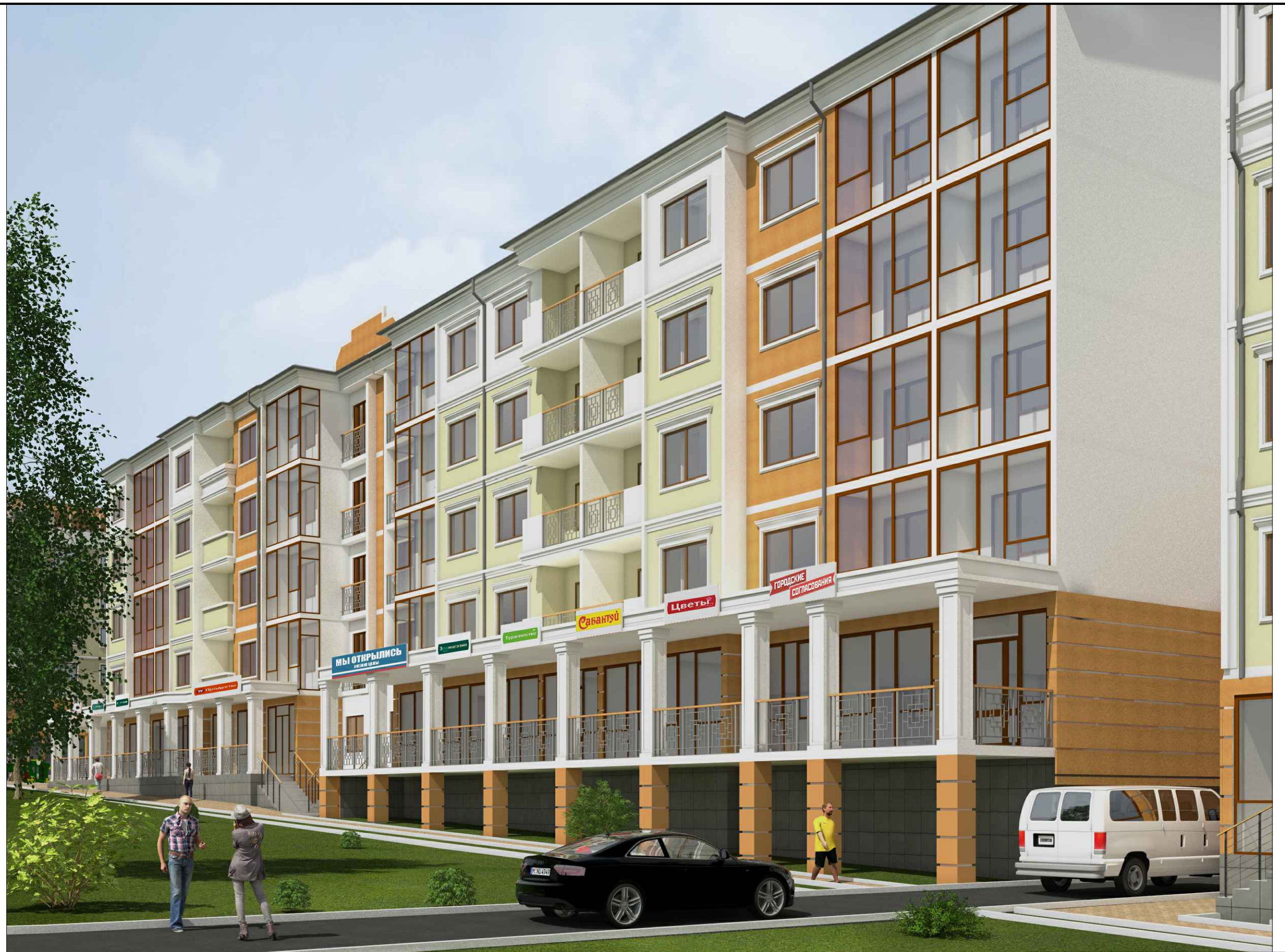
Жилой комплекс "Горизонт" по ул.Туристической в г. Геленджике
